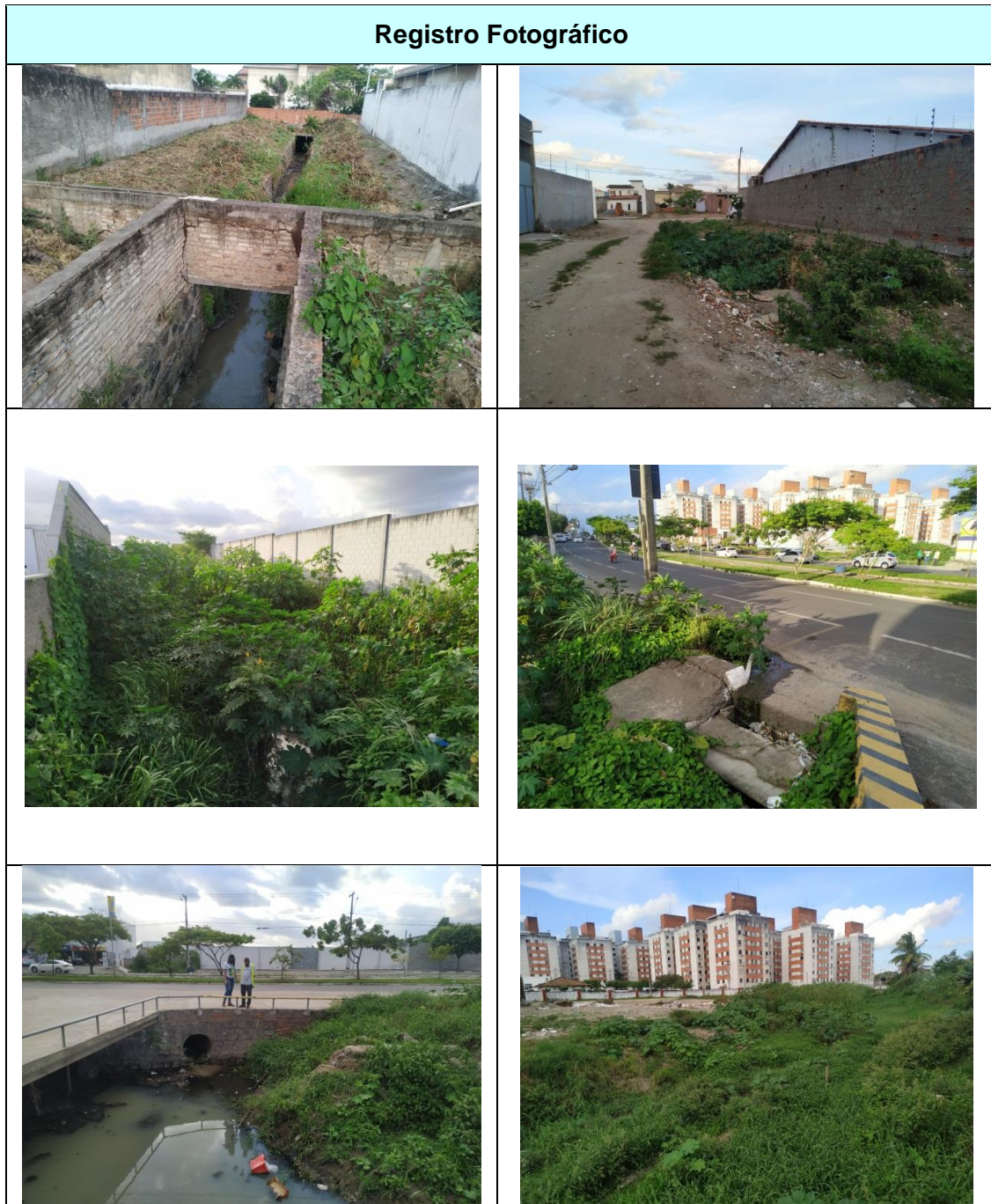
Quadro 20 – Registro fotográfico para o trecho 02 do Canal 03 e 14 – Riacho do João Paulo.
