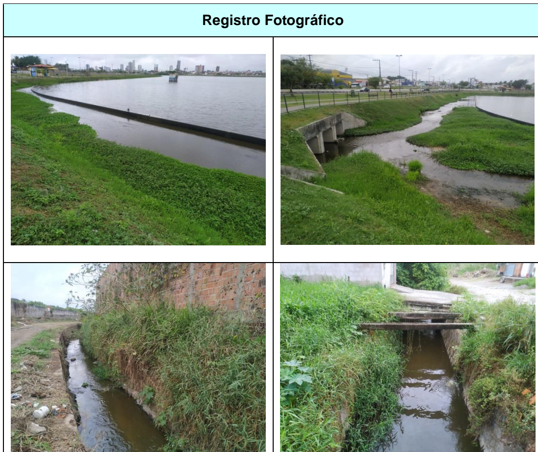
Quadro 15 – Registro fotográfico para o trecho 01 do Canal 02 – Riacho das Pedras.
