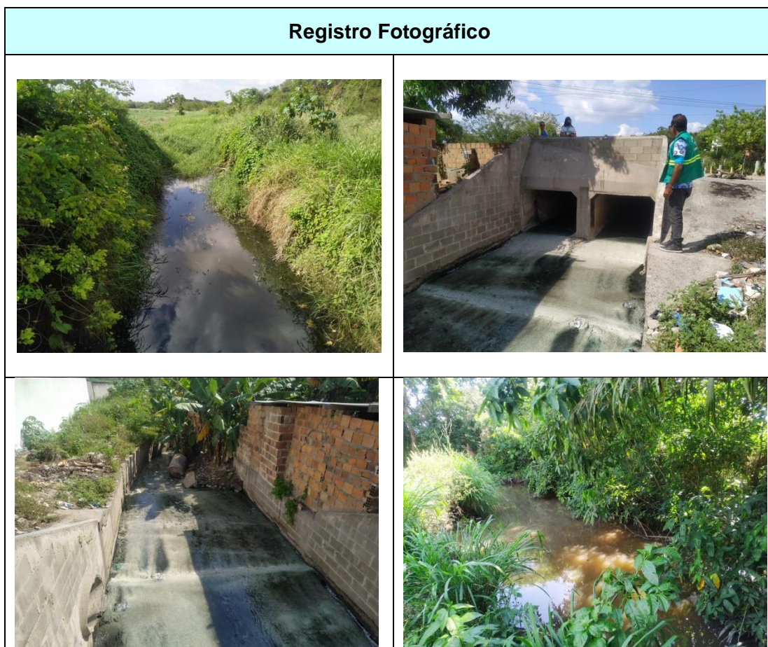
Quadro 14 – Registro fotográfico para o trecho 02 do Canal 07 – Rio Subaé.
