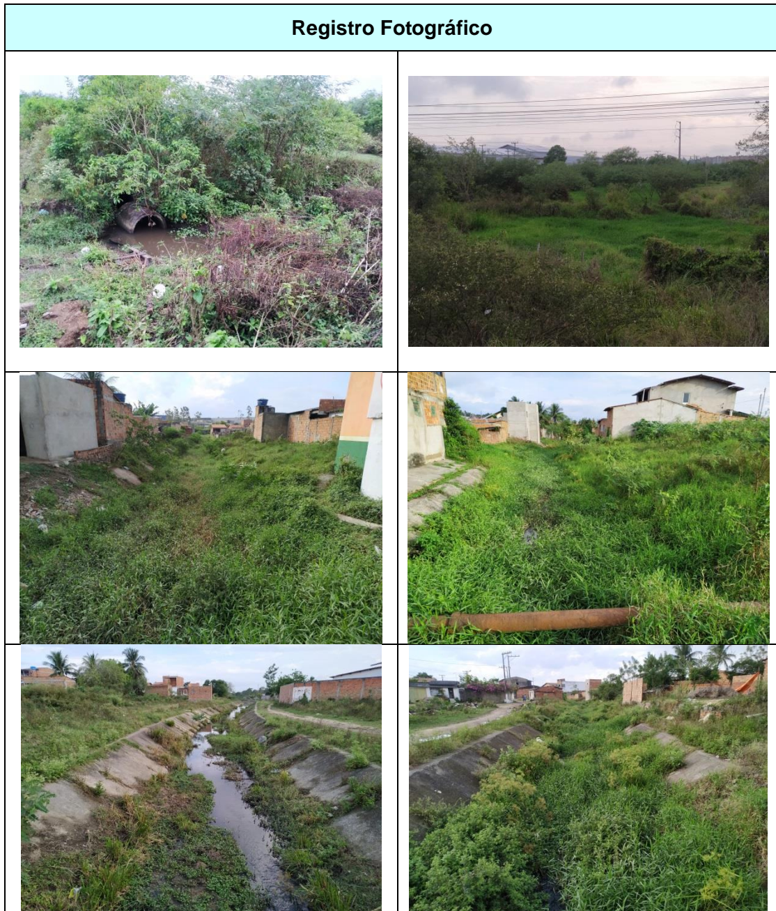
Quadro 12 – Registro fotográfico para o trecho 02 do Canal 06 – Rio Subaé.
