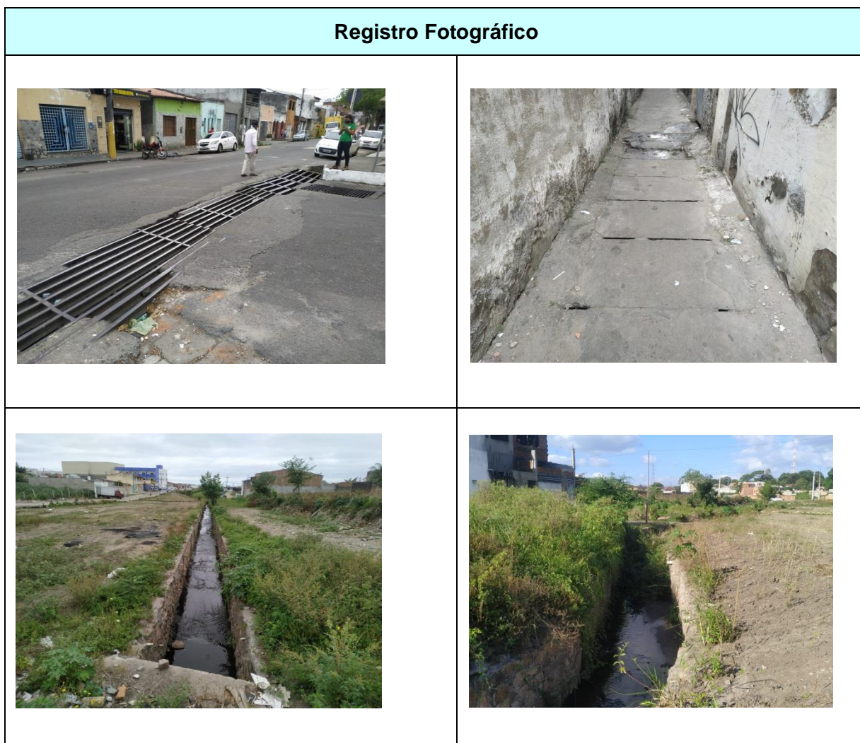
Quadro 6 – Registro fotográfico para o trecho 01 do Canal 09 – Riacho da Espuma.
