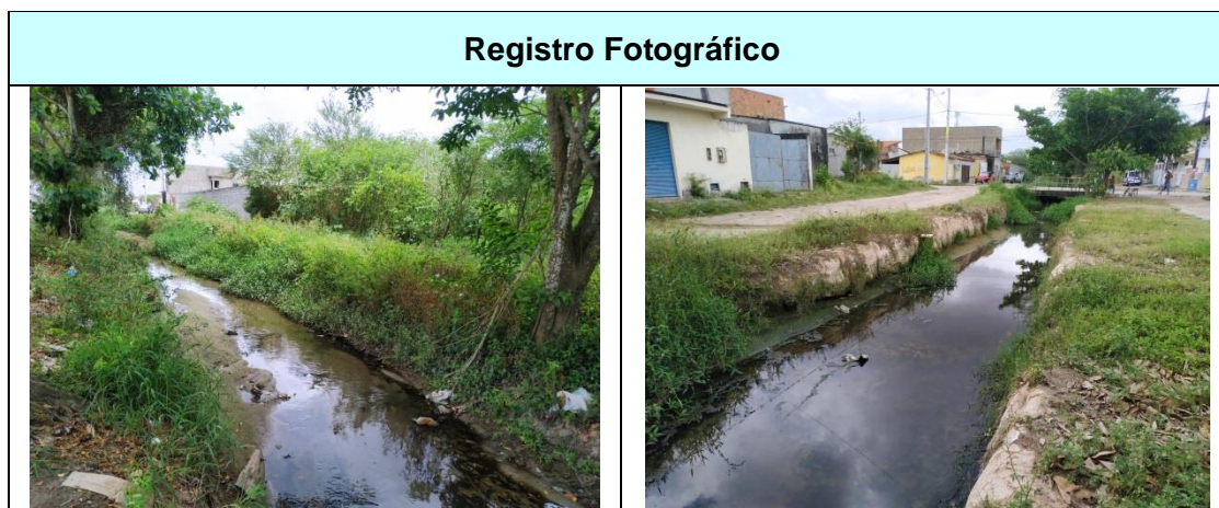
Quadro 22 – Registro fotográfico para o trecho 02 do Canal 05 e 12 – Riacho do Papagaio.
