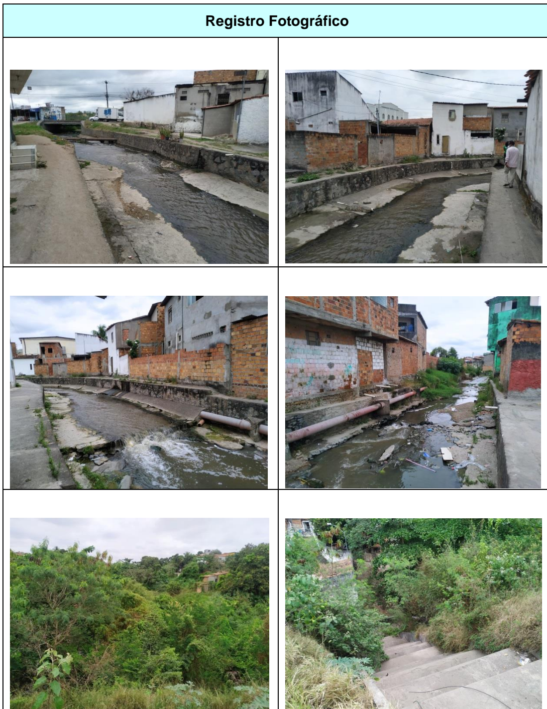
Quadro 7 – Registro fotográfico para o trecho 02 do Canal 09 – Riacho da Espuma.
