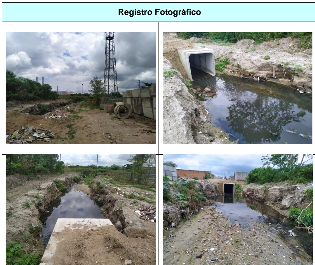
Quadro 17 – Registro fotográfico para o trecho 01 do Canal 03 e 14 – Riacho do João Paulo.
