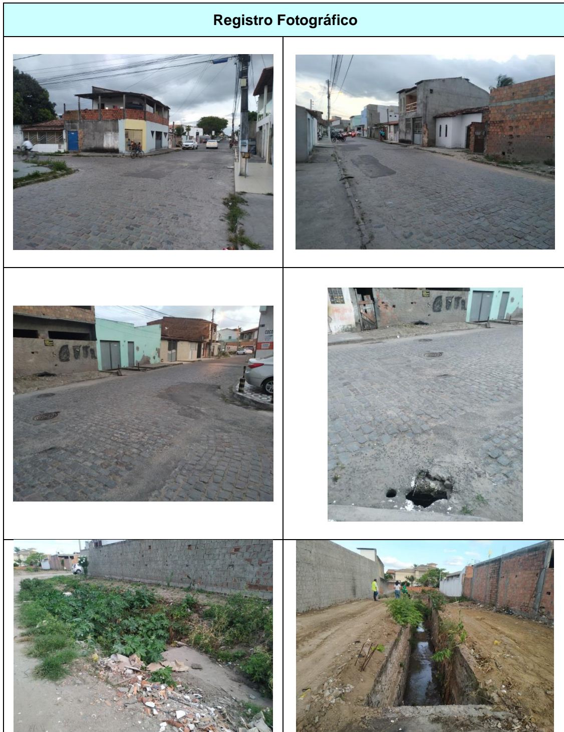
Quadro 19 – Registro fotográfico para o trecho 01 do Canal 04 e 13 – Riacho do João Paulo.
